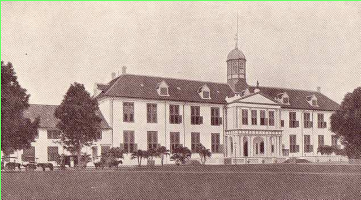
16. Voorgevel van het stadhuis, Batavia 1890
